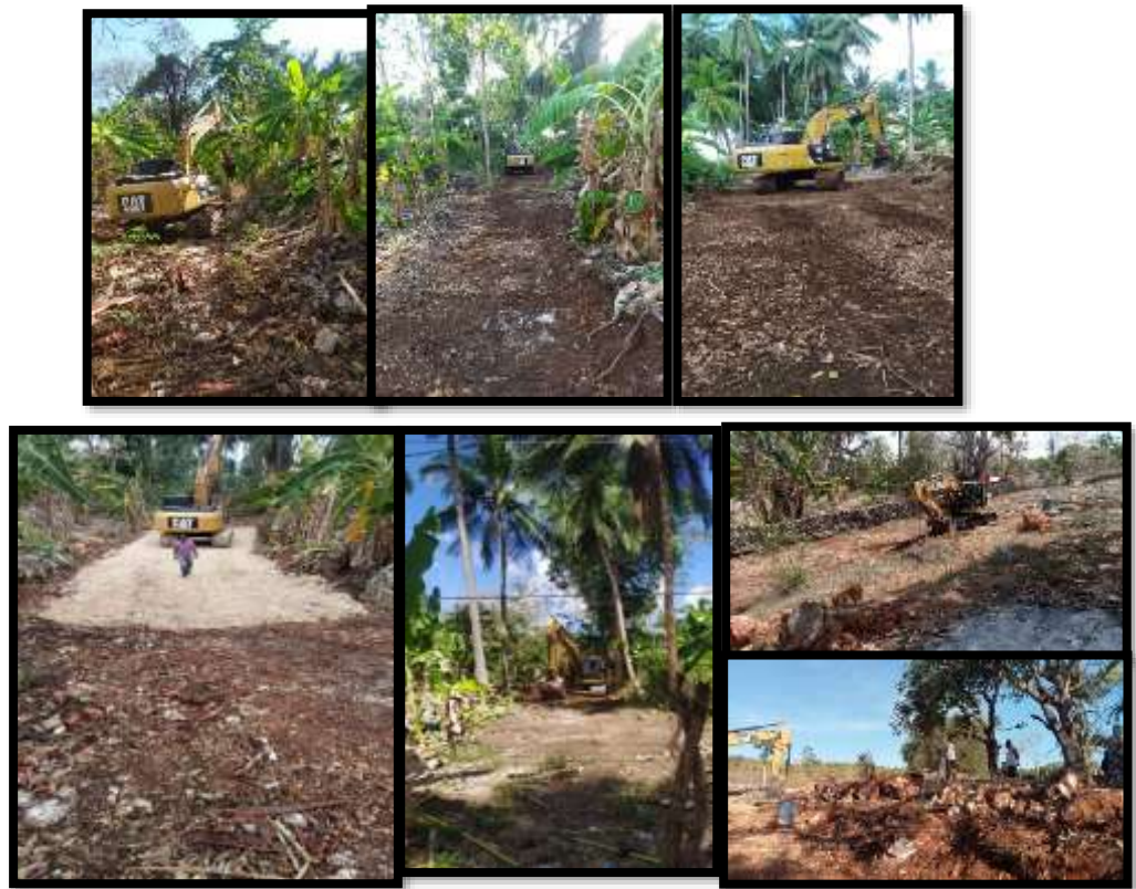
Gambar 37 .Pembangunan Jalan Tani Borong – Borong
