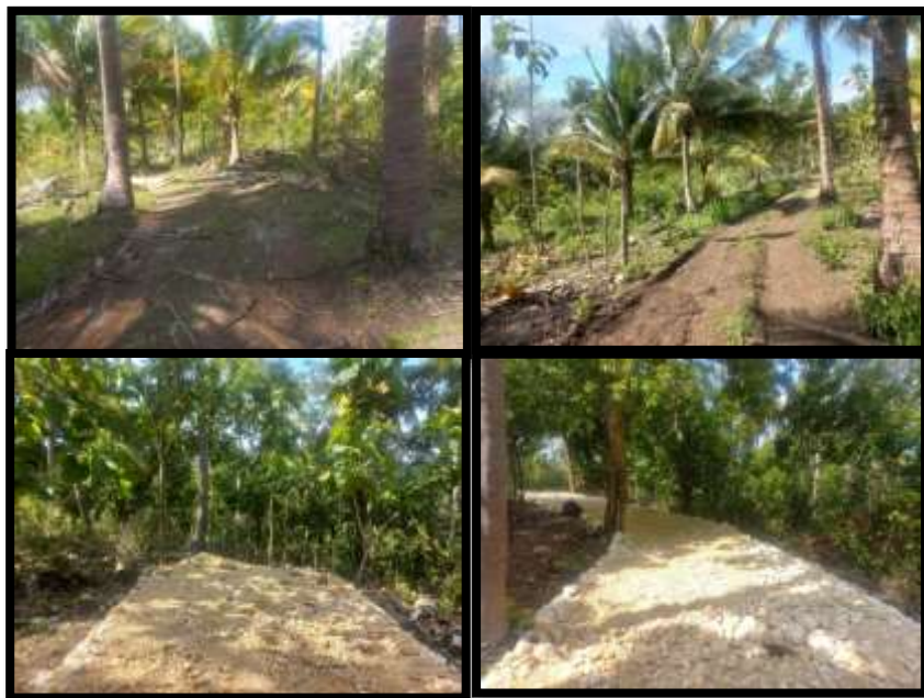
Gambar 36 Pembangunan Jalan Usaha Tani Ruas Kaburu – Katti – Katti
